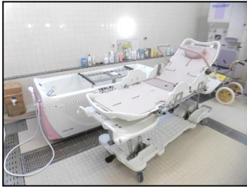
特殊浴槽設置
